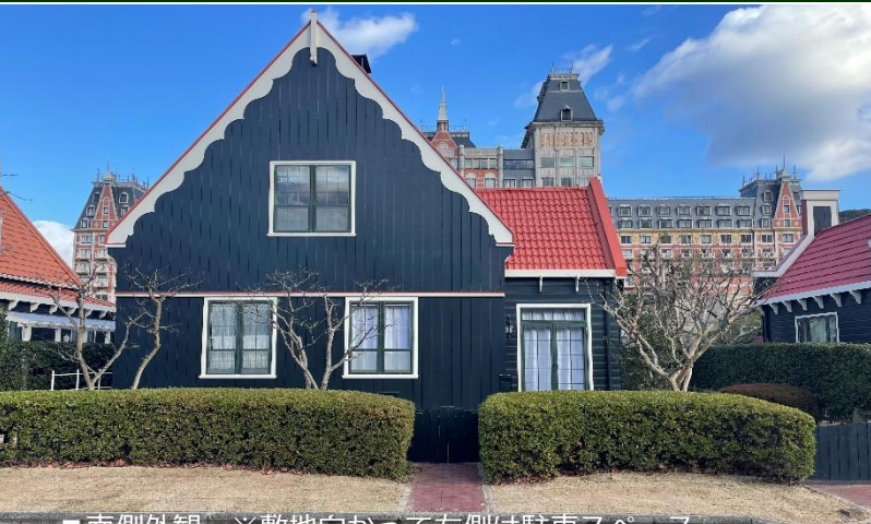
■ 南側外観、※敷地に向かって右側は駐車スペース (5m+前面3m)
